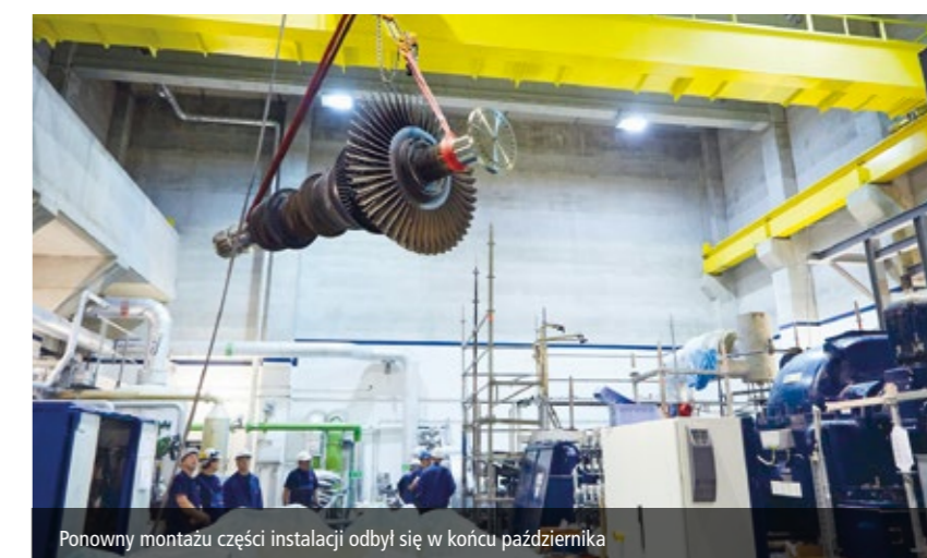
Zdemontowana turbina została przetransportowana do przeglądu do zakładów producenta
