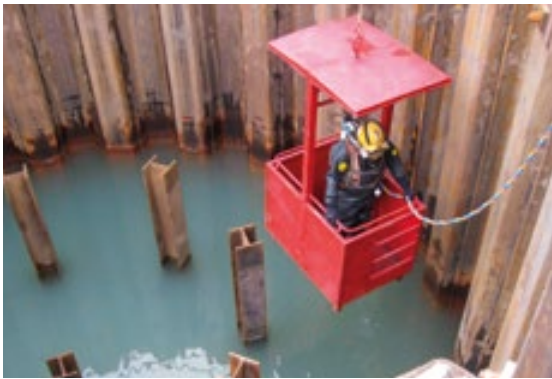
Remontowany odcinek głównego kanału ściekowego w Chociebużu leży na głębokości 7 metrów
