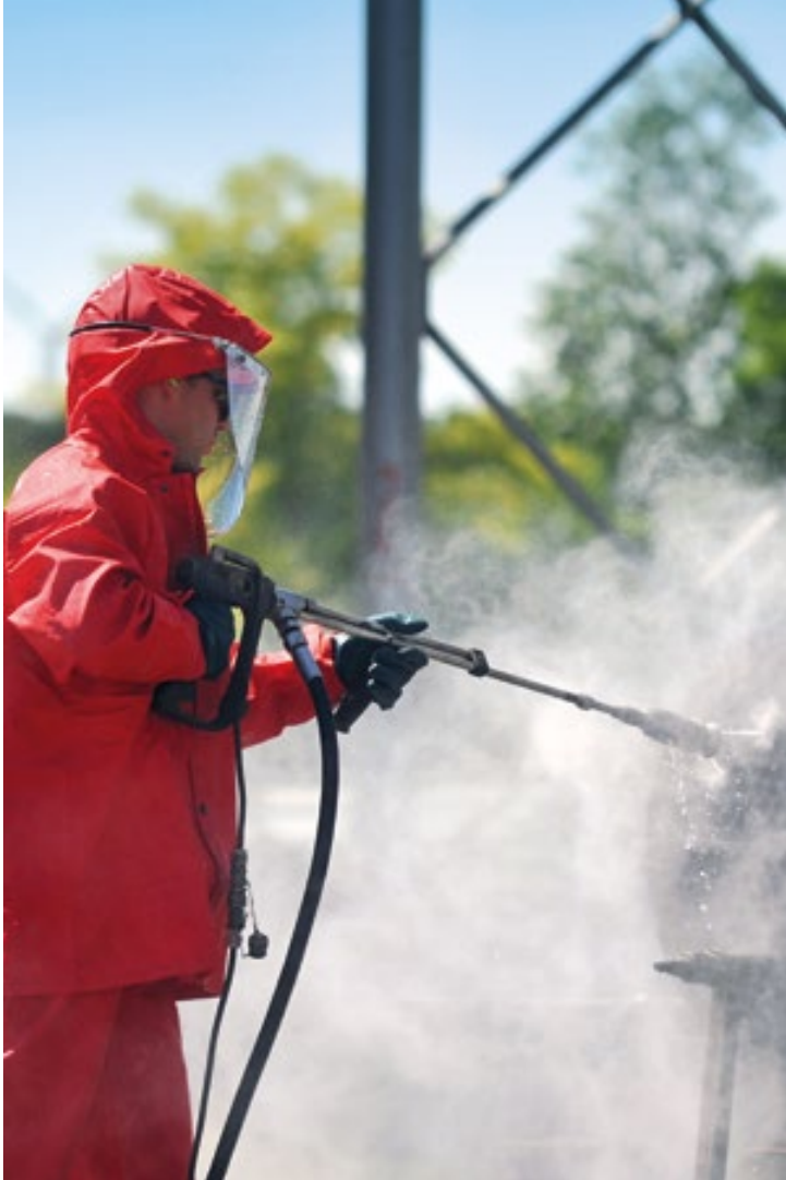
Wśród rozwiązań zaprezentowanych w Schwedt znalazło się czyszczenie przetwornika ciśnienia strumieniem wody pod wysokim ciśnieniem
