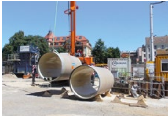
Nowo układane rury mają imponujące wymiary. Ich średnica zewnętrzna wynosi 1,72 metra
