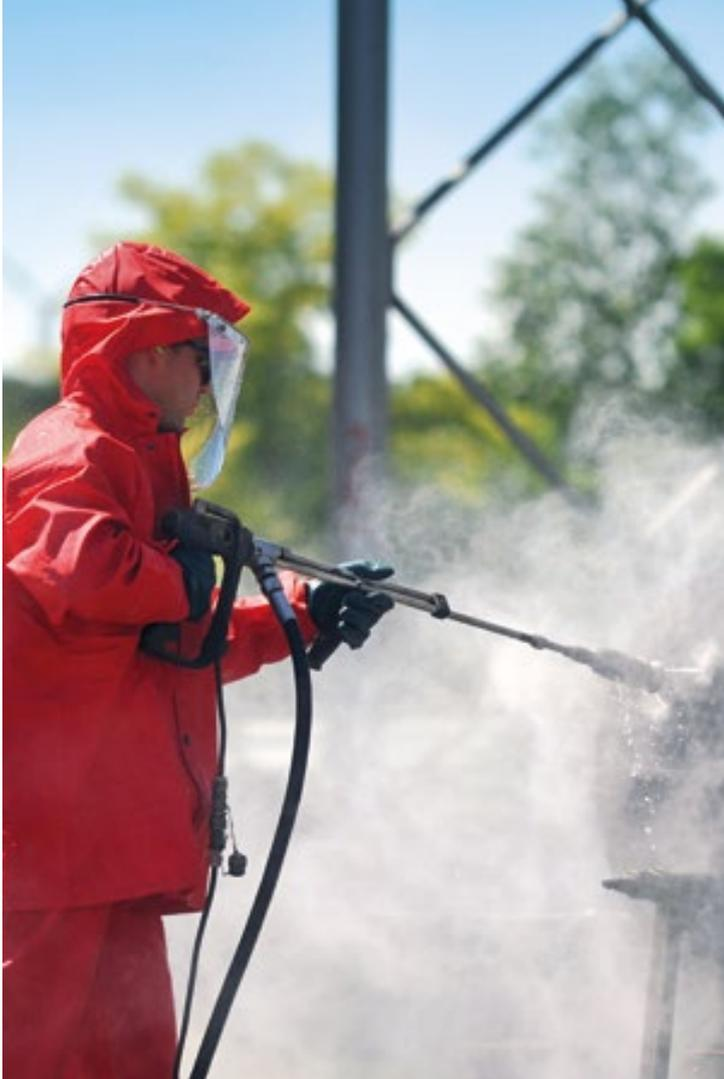
Zu den in Schwedt gezeigten Lösungen zählte die fachgerechte Wasserhochdruckreinigung eines Wärmetauschers
