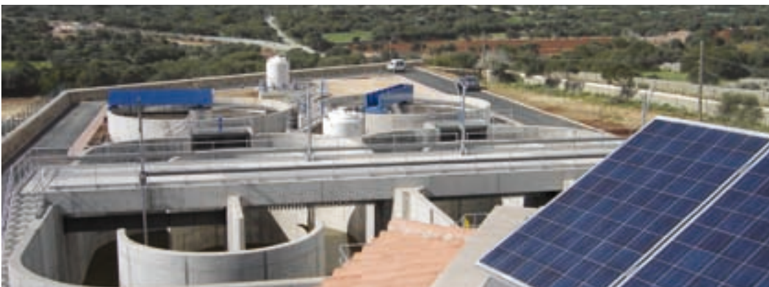
Cal en Porter, eine der modernen Wasseraufbereitungsanlagen von OMS in Spanien
