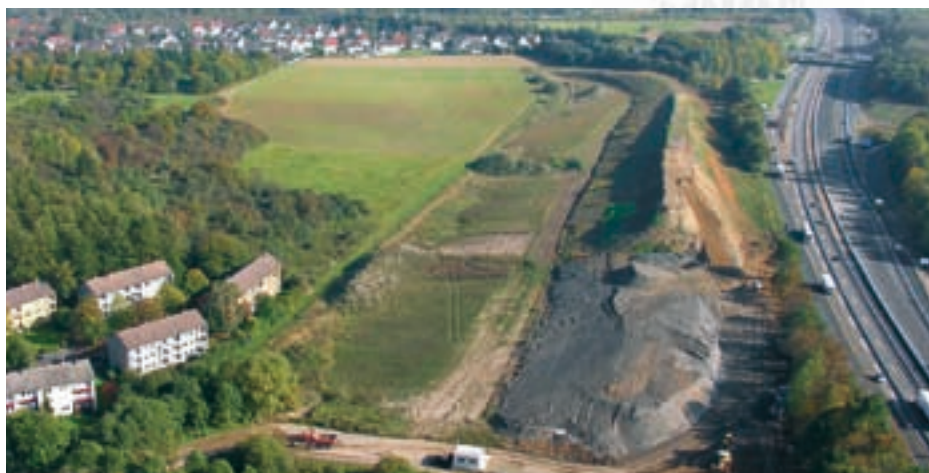
Luftaufnahme des Erdwalls an der A44 bei Kassel-Mattenberg während der Bauphase
