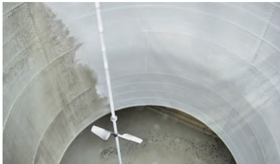
Nachher: Dank XERVON Oberflächentechnik konnte den zwölf Meter hohen Tanks ein frischer Anstrich verpasst werden. Zuvor wurde durch die REMONDIS-Tochter BUCHEN die Oberfläche von Anhaftungen befreit
