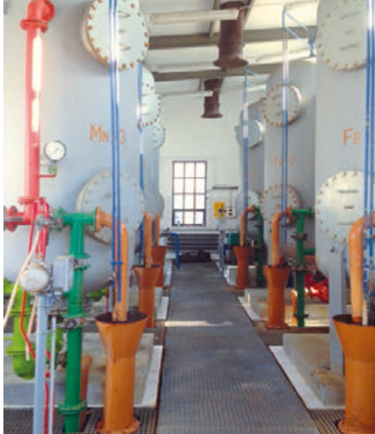
Das Wasserwerk von Wyszogrod hat umfassende Modernisierungen durchlaufen
