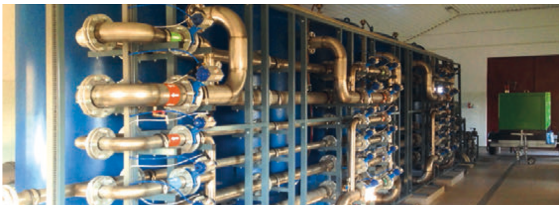
Auch in Kobylniki ist die wasserwirtschaftliche Anlagentechnik auf dem neuesten Stand
