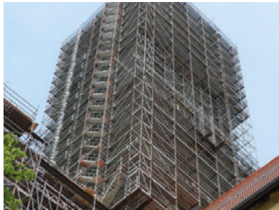
Die XERVON-Gerüstkonstruktionen an der Amberger Basilika sind bis ins kleinste Detail geplant und durchgerechnet – ein eindrucksvolles Beispiel für fachmännische Gerüstbautechnik
